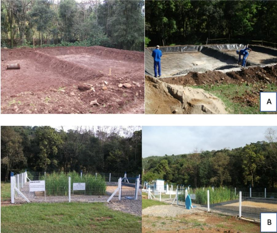
**Figura 7.2 – Sistema wetland de fluxo horizontal. (A) escavação e impermeabilização da unidade. (B) Unidade plantada em operação.**
