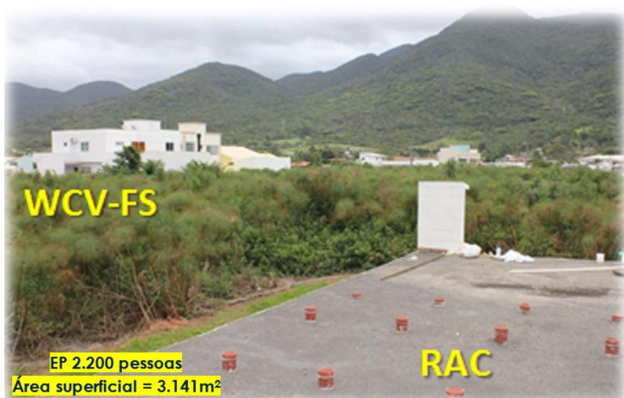
**Figura 1.8 – Representação parcial do módulo wetland construído vertical de fundo saturado empregado para o tratamento de esgoto doméstico implantado em um condomínio horizontal de residência, no município de Palhoça/SC.**
