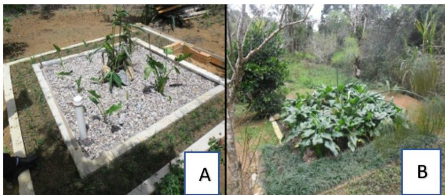
**Figura 7.8 – Wetland vertical afogado em operação; (A) mudas recém-plantadas; (B) sistema com cinco meses em operação.**
