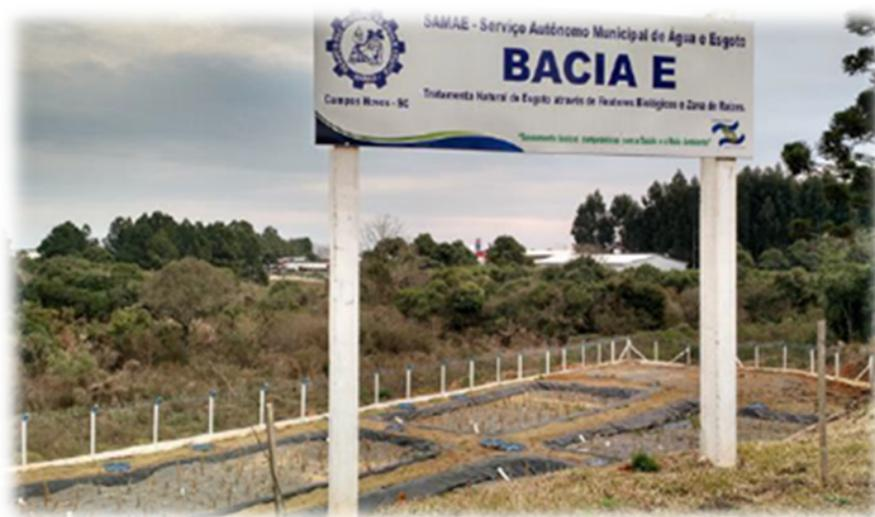
**Figura 1.9 – Representação parcial do módulo wetland construído horizontal empregado para o tratamento de esgoto sanitário implantado em um loteamento, no município de Campos Novos/SC.**
