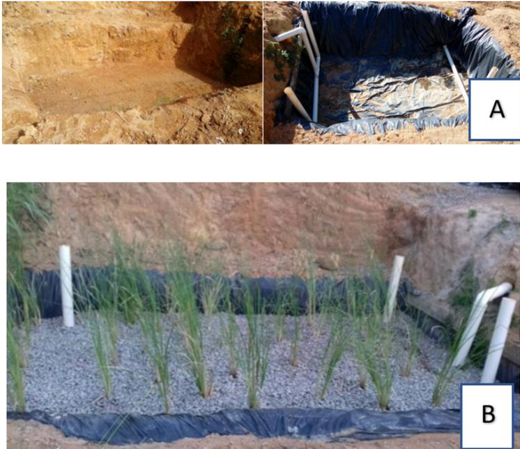
**Figura 7.5 – Wetland de fluxo horizontal implantado em unidade unifamiliar. (A) escavação e impermeabilização do tanque. (B) unidade plantada em operação.**
