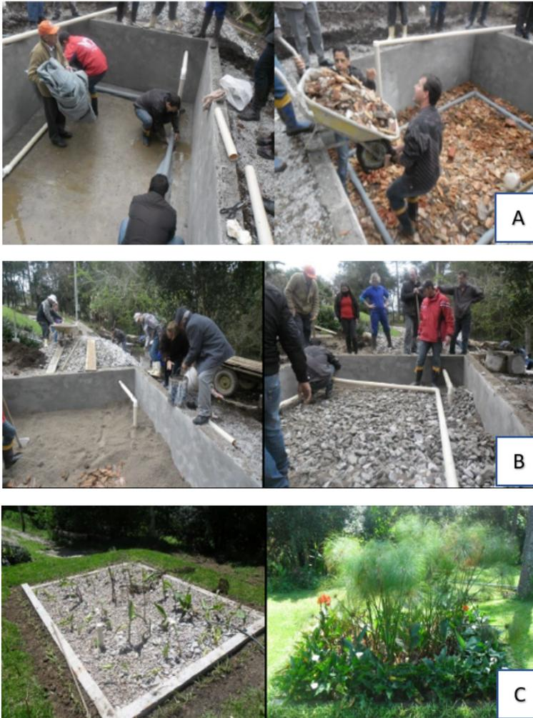
**Figura 7.4 – Etapas construtivas do wetland (A) colocação da tubulação de drenagem e da camada de entulho de base. (B) colocação da brita e da camada de areia. (C) unidade plantada em operação.**
